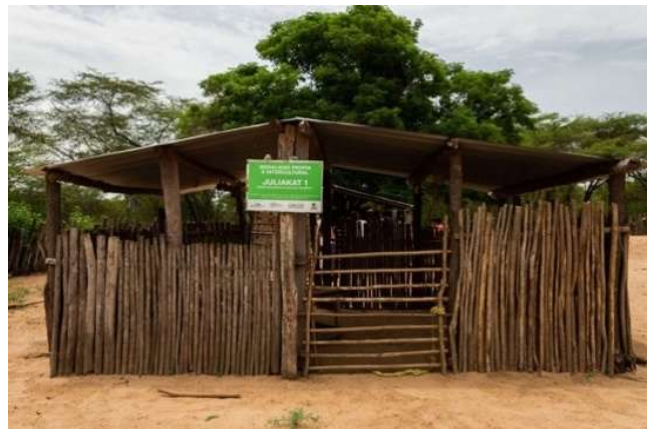
T. N 34 De contorno redondo, ovalado o cuadrado según se use, para cabras o para caballos, constituido en ramas entrelazadas o en varas paradas.
