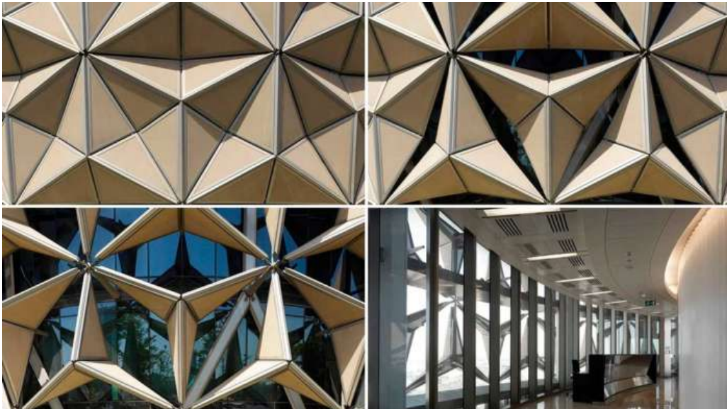
T. N 31 t demuestran cómo "sistemas de fachada responsiva pueden reducir ganancia solar en 50% mediante lógica paramétrica"
