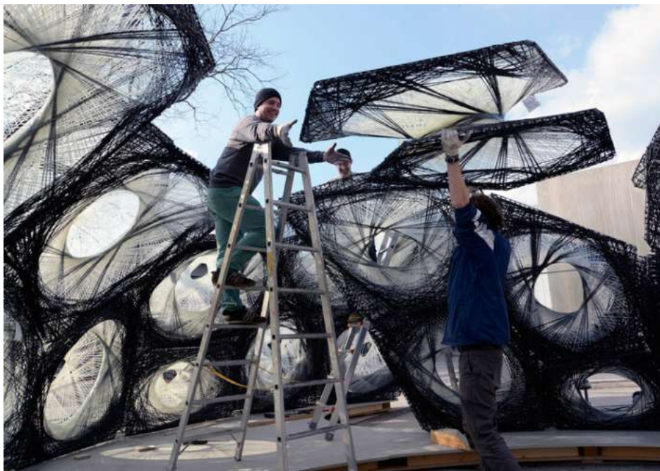
T. N 23 Se observa que se está armando el pabellón tejido.
